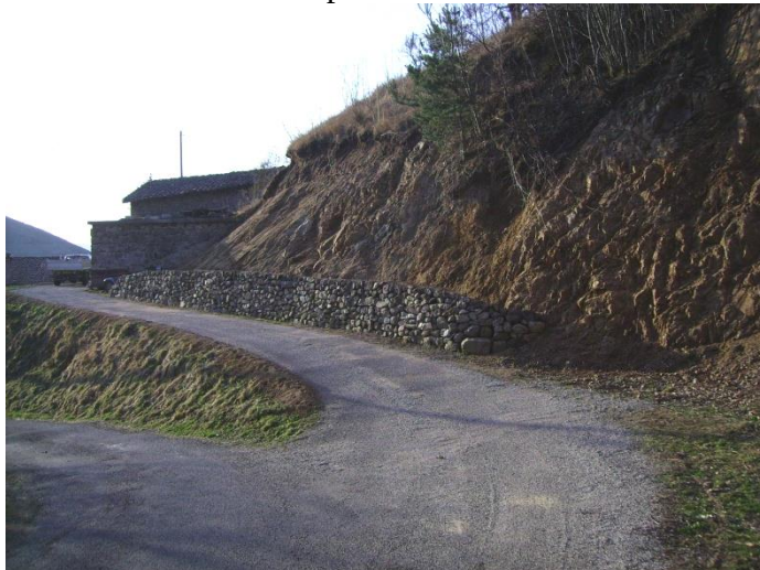
Construction d'un mur pour de soutènement de talus à Curins :
